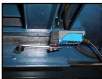
Концевой выключатель главного подъемника
