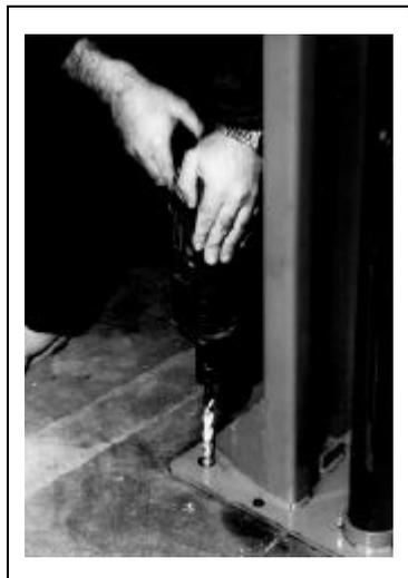
5. Установите стойку снова и затяните крепежные болты только с усилием, необходимым для удержания стойки в этом положении, (затягивание болтов динамометрическим ключом произвести только после сборки всей конструкции).
