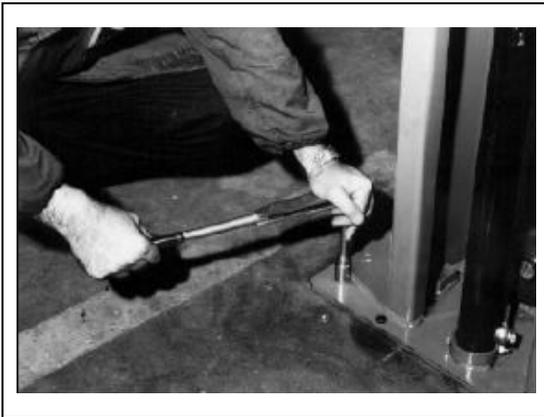
10. Закрепите стойку на основании, затяните анкерные болты динамометрическим ключом с усилием 110 Nm (Рис.38).
